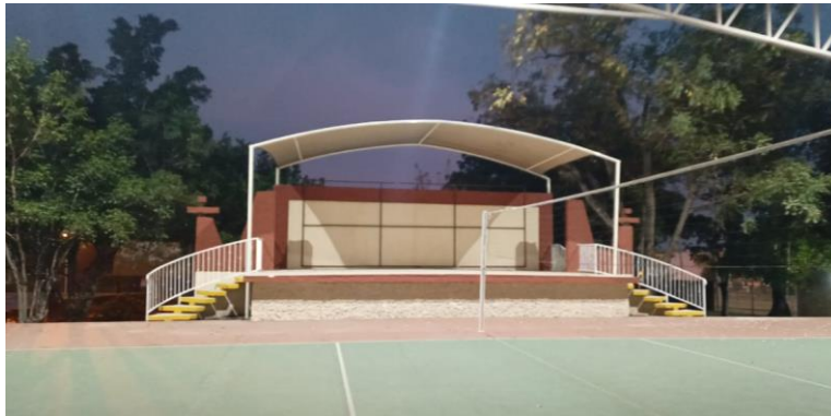
Fotografía 31. Instalación de toldo en el foro.
